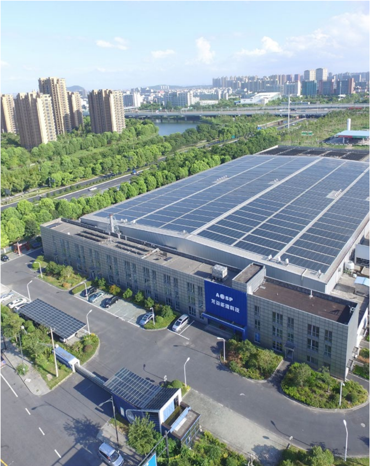
En av ASRE:s anläggningar i Kina om 1 MW, installerad på Advanced Solar Power Hangzhous fabrik.
