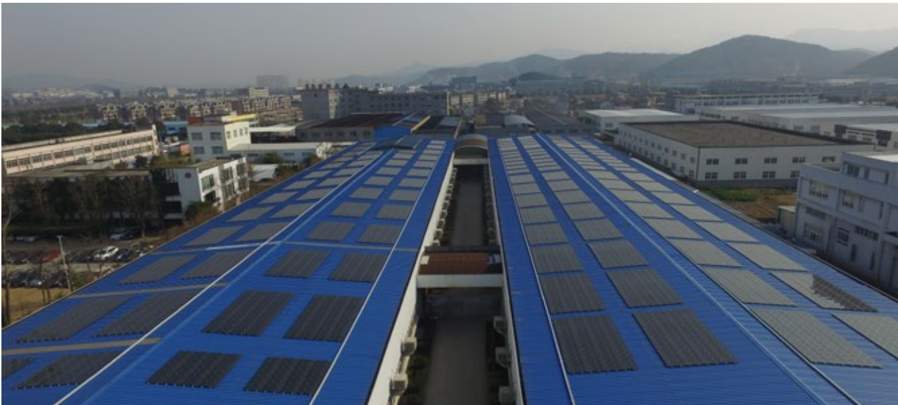
En av ASRE:s anläggningar i Kina om 450 kW installerat på Ningbo Sente Auto Parts Co. Ltd.
