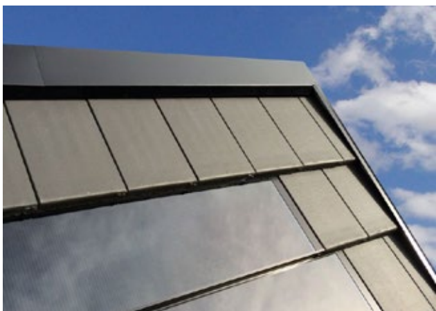
Bilden visar SolTech ShingEl som föresträdesvis används i ASRE:s installationer när kunden har ett pannbeklätt tak.
